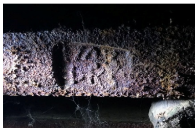
Рис. 5. Клеймо, расположенное на горизонтальном элементе стропил в северной части чердака
